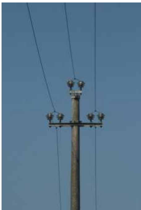
Linea MT : con palo in cemento e isolatori rigidi portanti doppi
