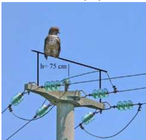
Isolatori per ammarro con sistema di attrazione sicuro Fonte LGMA
