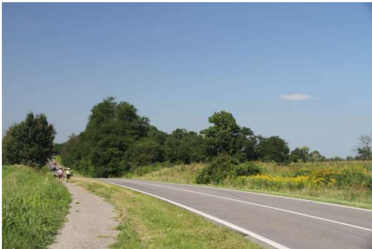
La S.P. 126 nel tratto alla periferia est dell'abitato di Somaglia
