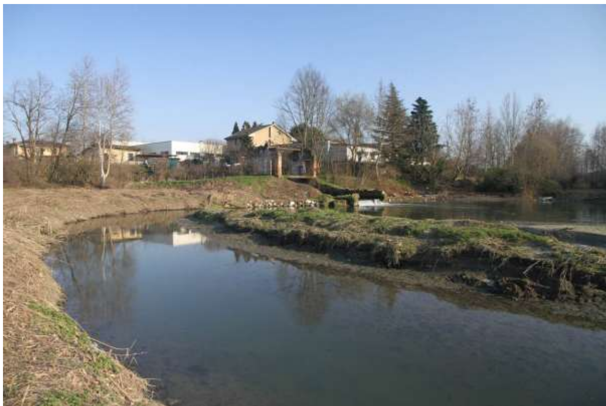
Gli edifici ubicati sulla riva orientale del Brembiolo
