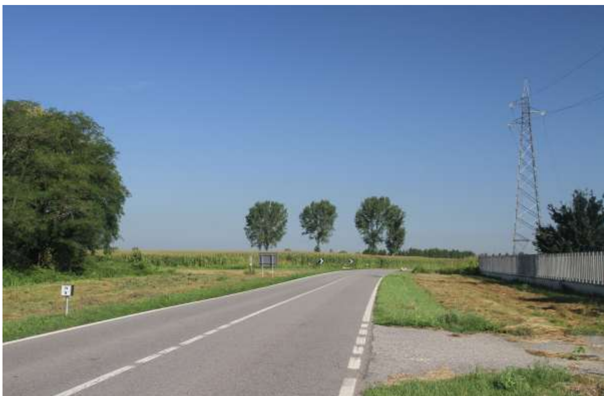
La S.P. 107 in corrispondenza della cabina elettrica
