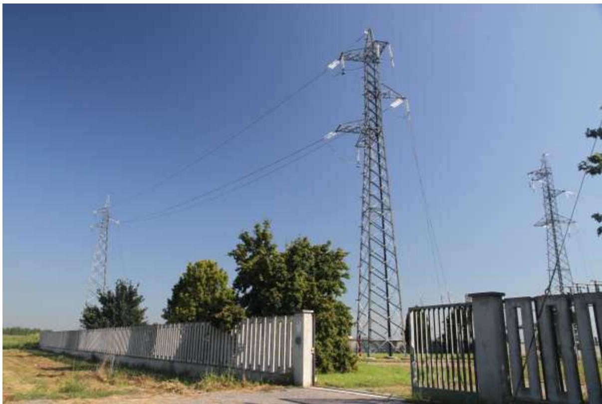
La cabina elettrica di scambio (settore nordovest dell'area)
