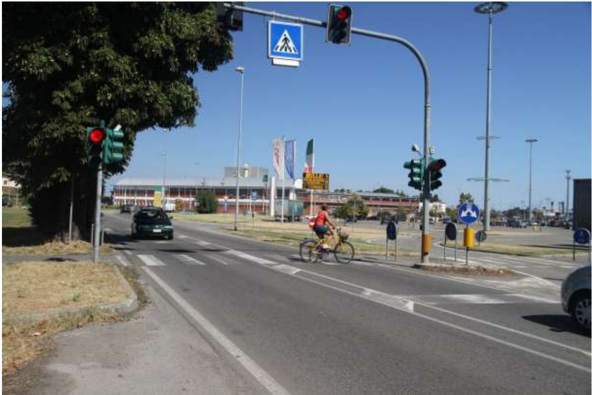
La S.S. 234 (Mantovana) nel tratto adiacente al Cimitero di Casalpusterlengo
