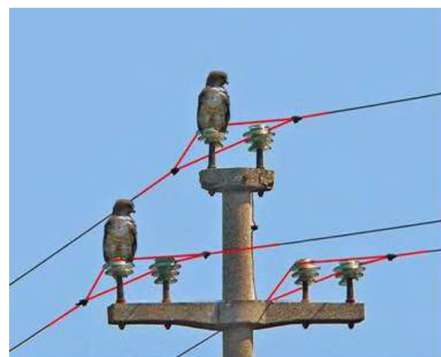
Isolatori portanti isolati con PVC Fonte LGMA
