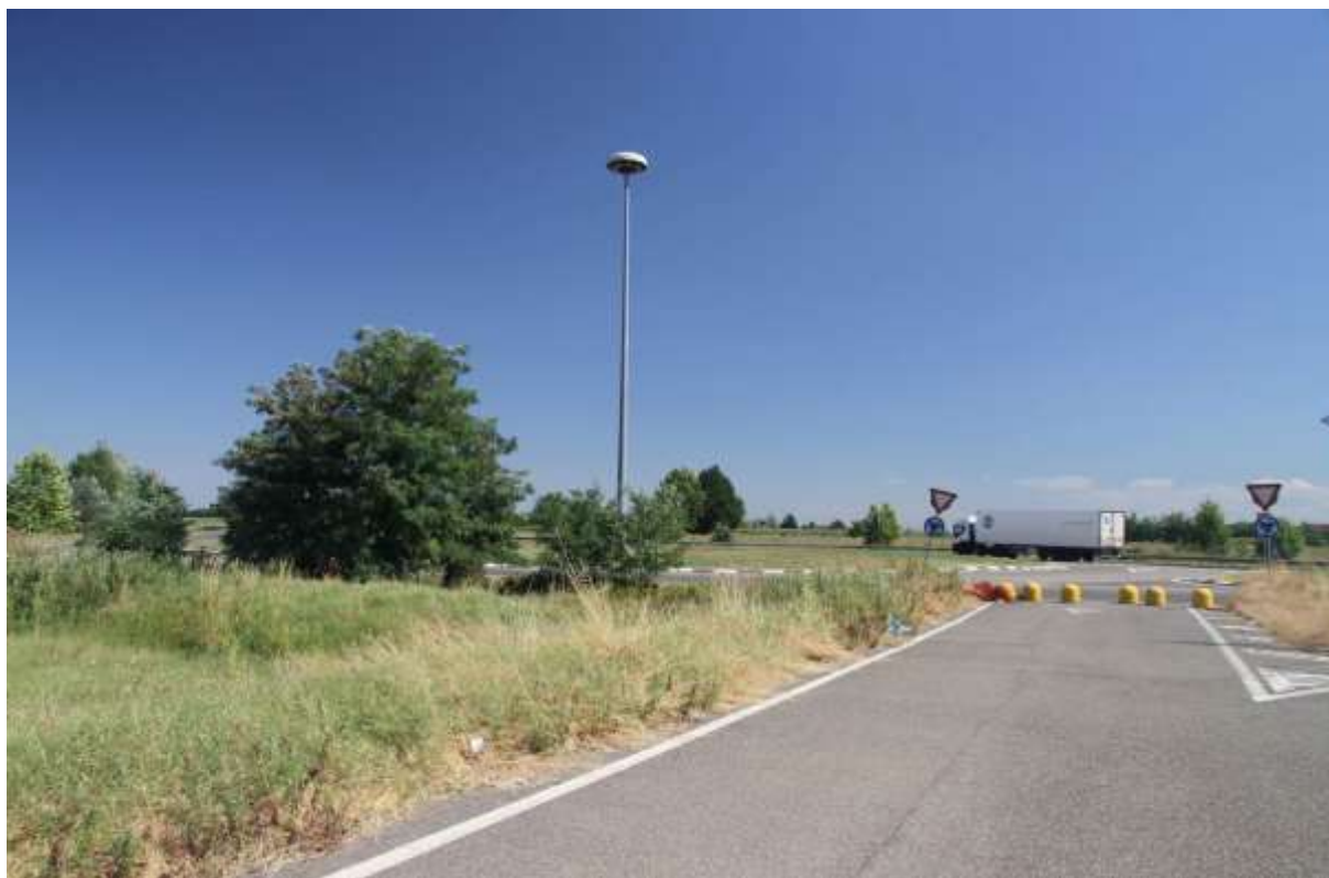
La rotonda in corrispondenza della S.P. 234, a cui dovrebbe raccordarsi la tangenziale di Casalpusterlengo
