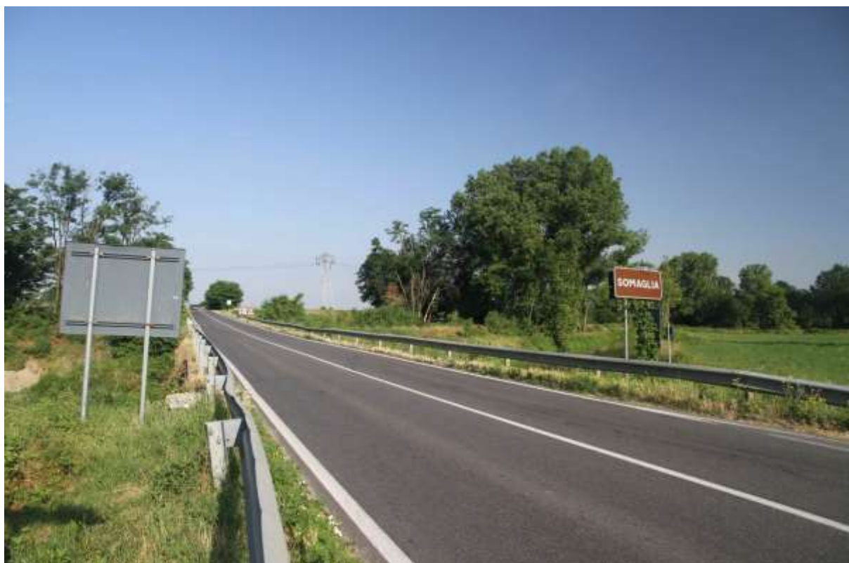
La S.P. 126, in corrispondenza del ponte sul Brembiolo
