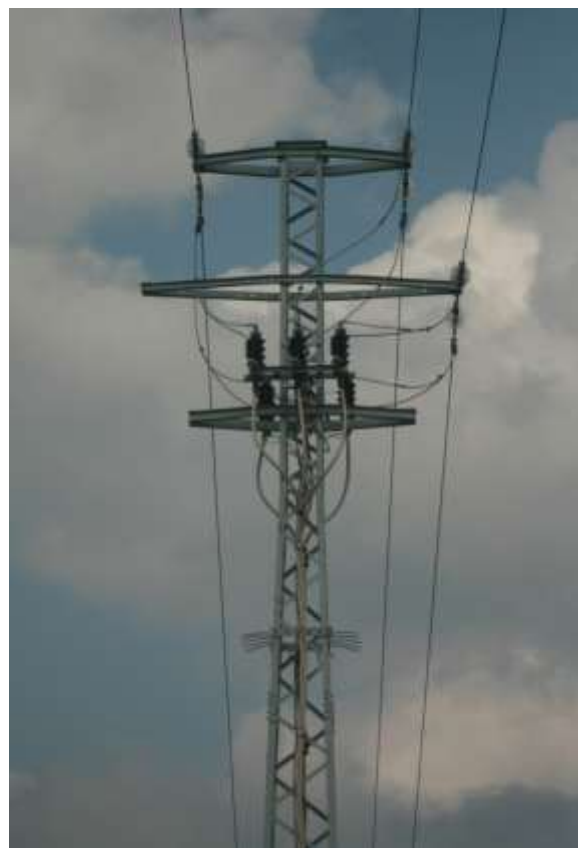
Sezionatore (a sinistra) e capolinea doppio (a destra)
