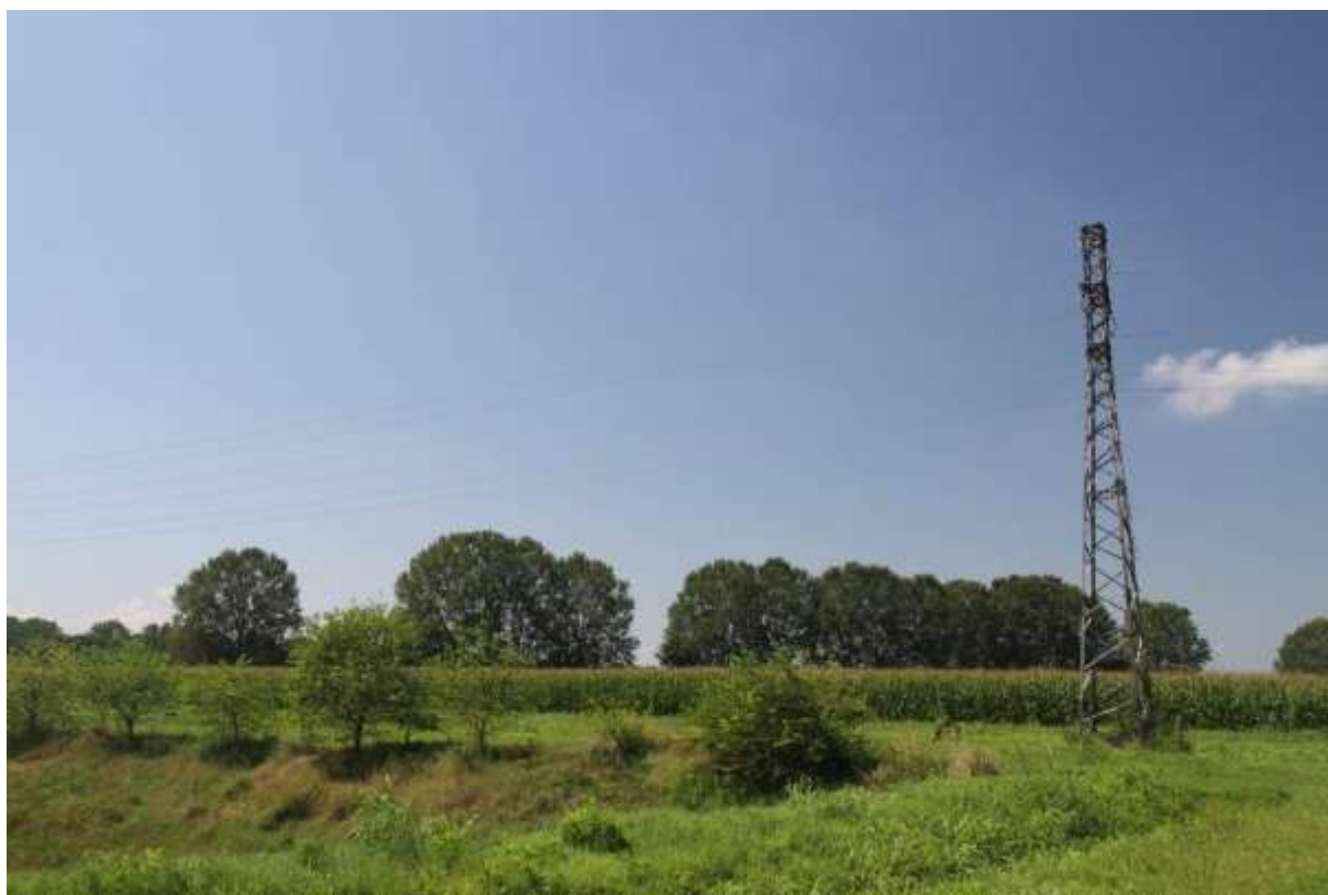
Linea elettrica nel settore nord dell'area
